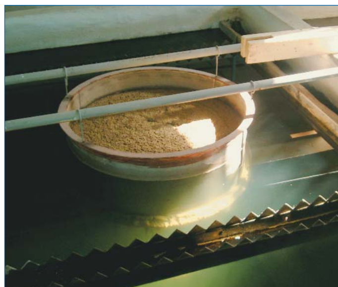
■ Рис. 3. Рабочая зона осветлителя после реконструкции на фильтровальной станции г. Чернушка
